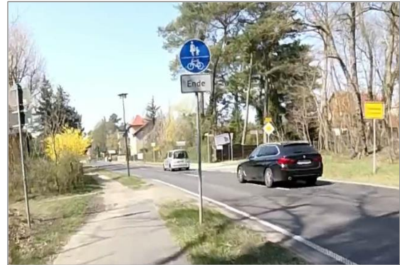
Abbildung 34: Ungesichertes Radwegeende auf der B96a Bergfelder Straße in Birkenwerder
