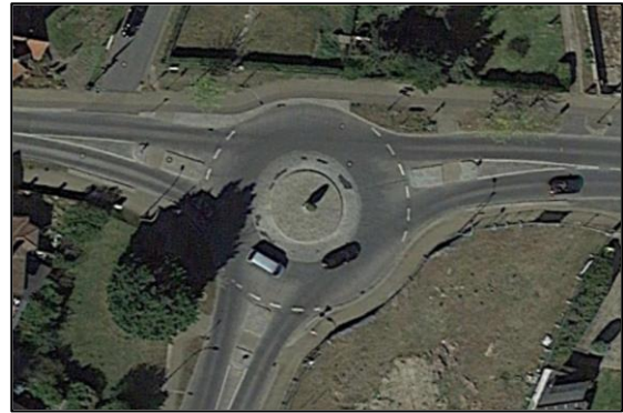
Abbildung 33: Kreisverkehr Kurt-Tucholsky-Straße/ Karl-Marx-Straße in Hohen Neuendorf
