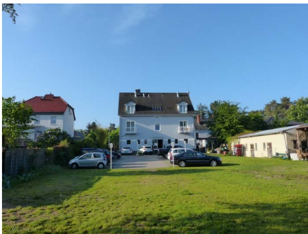
Blick von Nord nach Süd über das Plangebiet: Stellplatzanlage und dreigeschossige Pension, rechts ein vorhandenes Nebengelass
