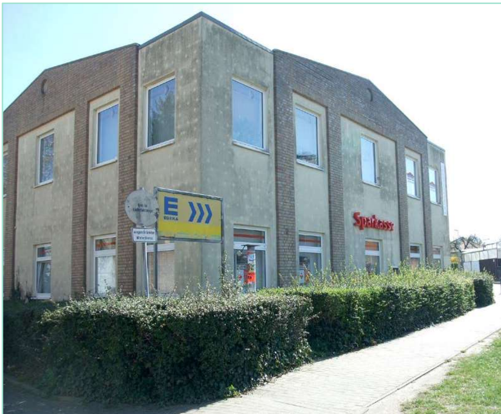
Untersuchungsgebiet Herrmann-Grüneberg-Straße in Mühlenbeck: Die südliche Baufläche ist bereits weitgehend versiegelt. Der westliche Teilbereich ist zweigeschossig bebaut. Ein großer Teil der Dachkanten ist als Tagesversteck für Fledermäuse geeignet.
