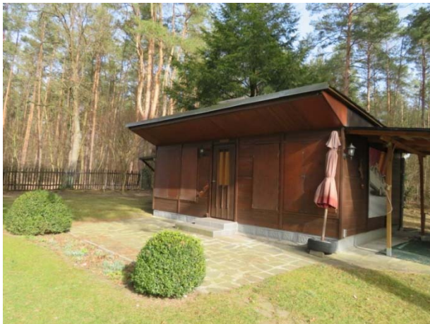
Grundstück Neue Bahnhofstraße 23 mit Baufeld 10: Hauptgebäude Blick aus SW
