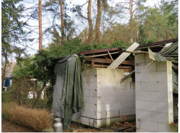
„Hauptgebäude“ im Nordteil auf Baufeld 6, dahinter die Bäume 56-60 und 62 (Kiefern)
