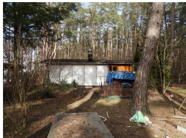
Hauptgebäude Neue Bahnhofstraße 24 im Baufeld 12, Im Vordergrund Baum Nr. 101 (Kiefer)
