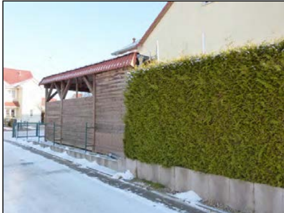
Carport mit Schuppen am Buchenhof
