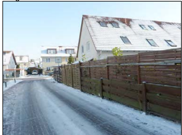
Einfriedung Am Lärchensteig
