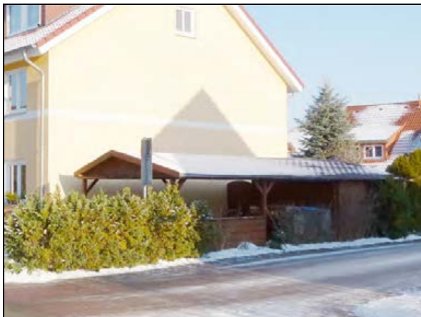
Carport mit Schuppen Weißdornweg
