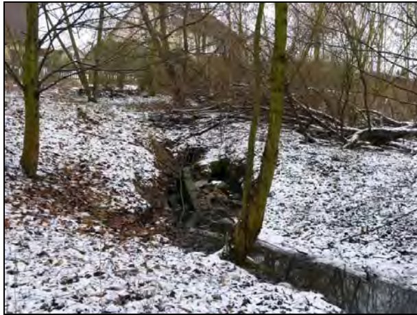
Einlaufbauwerk Regenwasser aus dem Plangebiet Blick nach Ost
