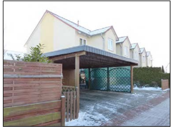
Carport Am Lärchensteig
