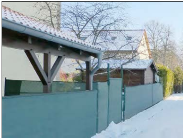
Einfriedung, Carport und Schuppen am Weißdornweg
