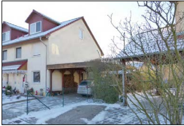
Lindensteig, Carport mit Flachdach aus Holz seitlich am Giebel eines Doppelhauses, auch diese Bauform wurde im Rahmen der Umsetzung des Ursprungsplanes mehrfach realisiert.
