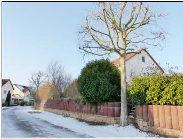
Stützwand aus Bossensteinen im südlichen Teil der Ebereschenstraße nahe der Lindenstraße, Ansicht von Ost Auf der Stützwand wurde eine Wand aus Hangsteinen als Erhöhung der Stützwand errichtet.
