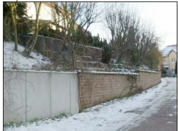
Ringstraße, Mitte, Ostseite, Übergangsbereich zwischen Stützwand aus Winkelsteinen mit darüber liegender Böschung und Stützwand aus Bossensteinen mit Aufbauten aus zusätzlichen Hangsteinen aus Beton Die Stützwand aus Bossensteinen hält dem Druck der zusätzlichen Aufschüttung nicht Stand und neigt sich zur Straße hin.
