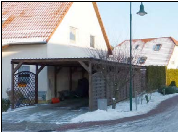
Carport Am Lärchensteig
