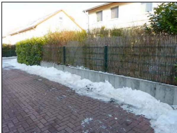
Stützwand auf der östlichen Seite der Straße am Lindensteig
