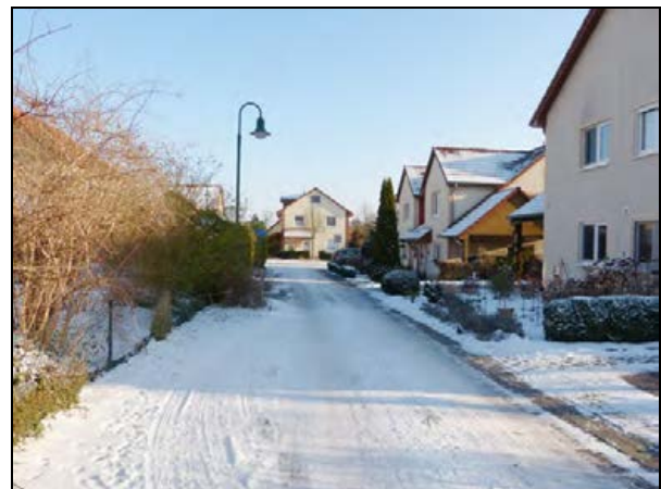
Lindensteig, Ausfahrt zur Lindenstraße, Blick in Richtung Ost, die nördlich (links) angrenzenden Gartenbereiche liegen etwas höher und fallen mit einer Böschung zur Straße hin ab.
