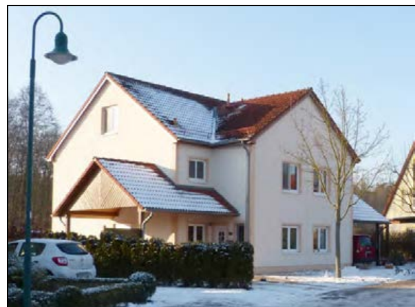
Am Pfaffenwald, Verbindung von Carport und Eingangsüberdachung entsprechend der ursprünglichen Planung einiger Doppelhaustypen
