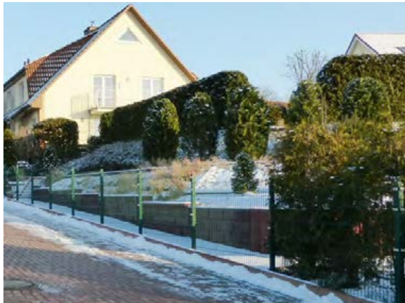
Zurück gesetzte Stützwand hinter der Grundstücksgrenze Ringstraße / Ecke Ebereschenstraße
