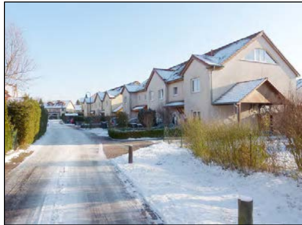
Reihenhäuser Weißdornweg Südseite
