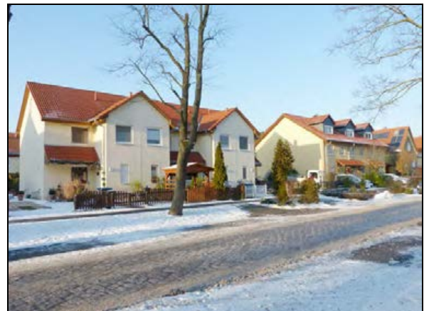
Reihenhaus und Mehrfamilienhaus Franz-Schmidt-Straße
