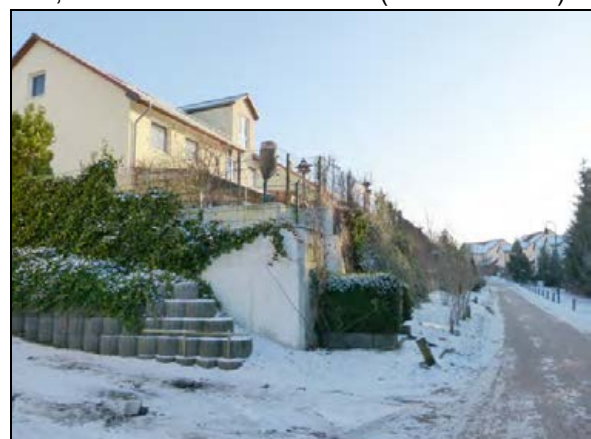
Böschung und Stützwand an der Ebereschenstraße (nördlicher Teil)
