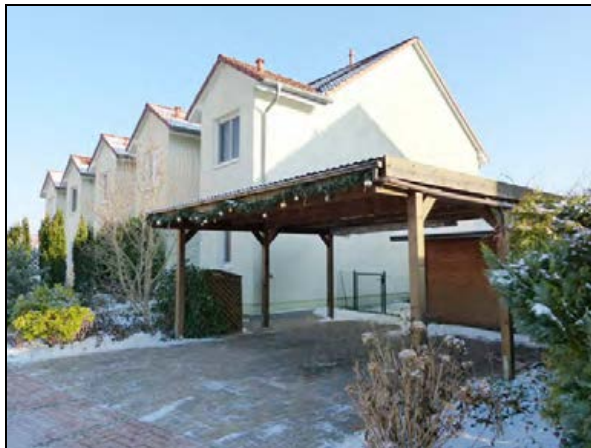
Carport Am Lärchensteig
