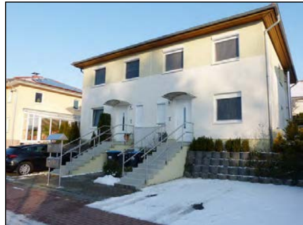
Böschung im Bereich der Hauptgebäude, abgefangen mit zusätzlicher Stützwand aus Hangsteinen, an der Ebereschenstraße (nördlicher Teil)
