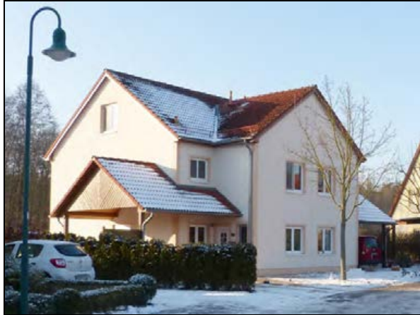
Am Pfaffenwald, Verbindung von Carport und Eingangsüberdachung entsprechend der ursprünglichen Planung einiger Doppelhaustypen
