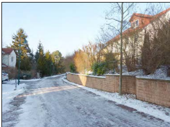
Stützwand aus Bossensteinen im südlichen Teil der Ebereschenstraße, Ansicht von Ost In diesem Abschnitt ist oberhalb der Bossensteinwand noch die ursprünglich geplante Ausführung mit flacher Böschung vorhanden. Hier steht die Bossensteinwand noch senkrecht.
