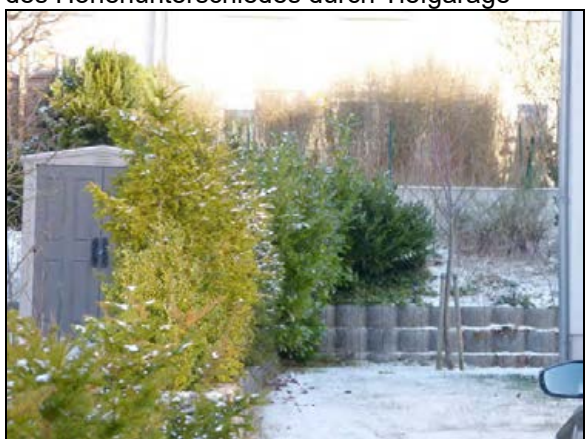
Böschung mit 2 Stützwänden in den rückwärtigen Grundstücksteilen zwischen Ebereschenstraße und Am Lärchensteig
