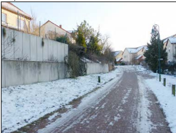
Stützwand aus Winkelsteinen aus Beton und darüber befindlicher Einzäunung an der Ebereschenstraße (nördlicher Teil)
