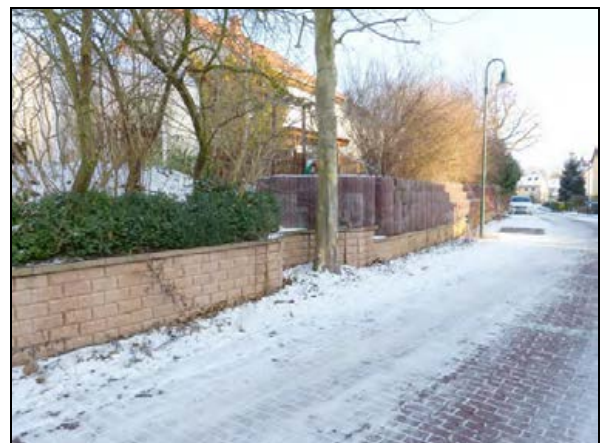
Stützwand aus Bossensteinen im südlichen Teil der Ebereschenstraße nahe der Lindenstraße, Ansicht von West Auf der Stützwand wurde eine Wand aus Hangsteinen als Erhöhung der Stützwand errichtet.
