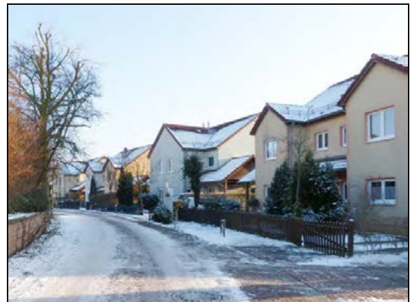
Doppelhäuser Ebereschenstraße südöstlicher Teil, Südseite
