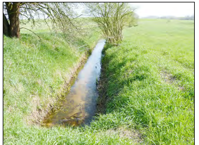
Schönwalder Südgraben, Blick von Nord (April 2018)
