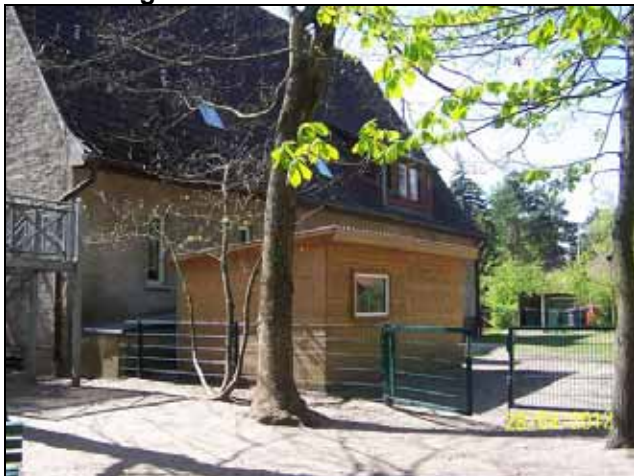
Auf der Nordseite des Kita-Gebäudes ist ein Schuppen vorhanden.
