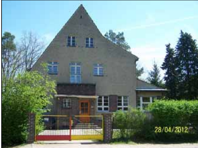
Ansicht von der Fritz-Reuter-Straße (von West)
