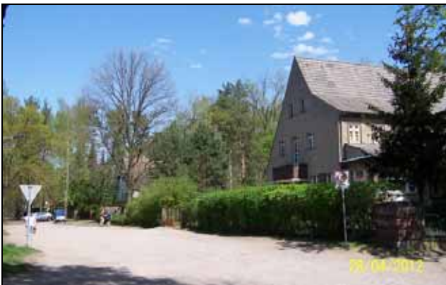
Die Fritz-Reuter-Straße westlich des Plangebietes ist ca. 13m breit und unbefestigt. Es handelt sich um eine Gemeindestraße, die die Funktion einer Anliegerstraße hat. Die zulässige Höchstgeschwindigkeit ist auf 30 km/h begrenzt.
