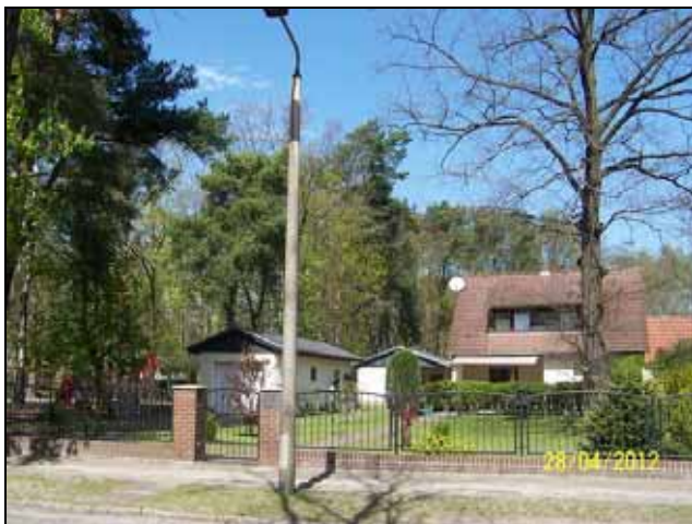
Einfamilienwohnhaus an der Schillerstraße östlich angrenzend an das Plangebiet
