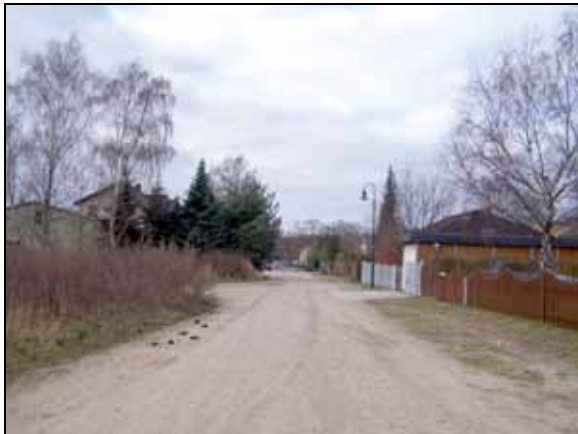
Magdalenenstraße im Bereich des Plangebietes, Blick nach West (Foto August 2008)
