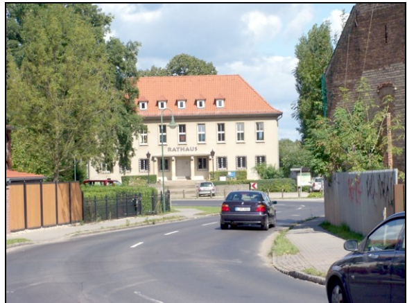
Hauptstraße (L21), Blick aus Richtung Ortskern zum Rathaus, das im Plangebiet liegt
